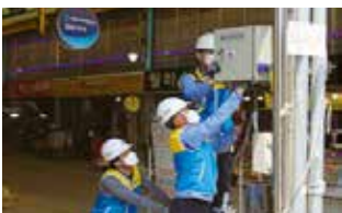
조치원 전통시장 내 전기 안전 분전함 설치
